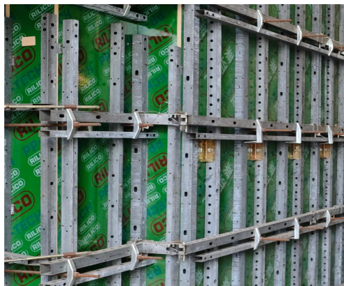
剪力墙轻量化模架体系
