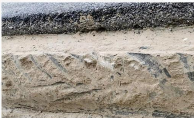
压实型低碳固化土稳定基层
