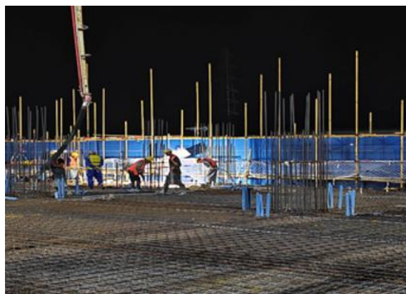
混凝土浇筑
